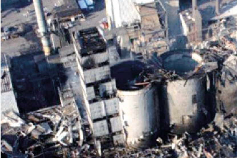
Figura 3. Un'immagine della Imperial Sugar Company distrutta dalle esplosioni e dall'incendio. (Foto: U.S. CHEMICAL SAFETY AND HAZARD INVESTIGATION BOARD, INVESTIGATION REPORT)
