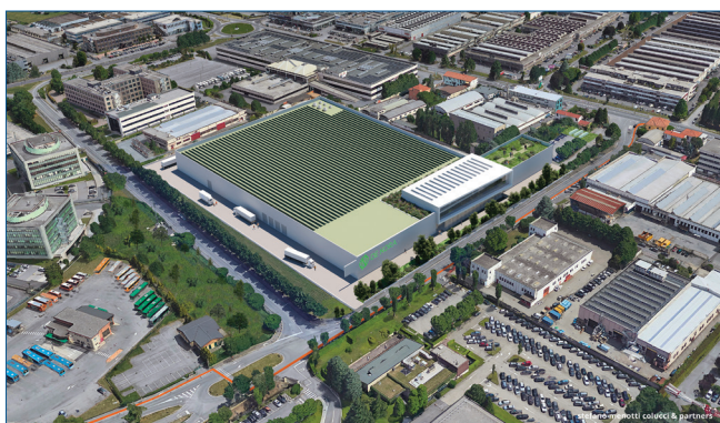
Fig. 4 - De Nora ha finalizzato l'acquisizione di un'area industriale dismessa a sud-est di Cernusco sul Naviglio (Milano, Italia) per realizzare la “GigaFactory”
