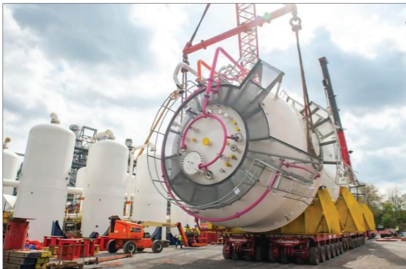
Fig. 6 - Reattore di fermentazione per la produzione di etanolo da off-gas da BF/BOF (courtesy of LanzaTech)
